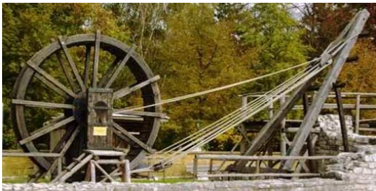
Abb. 17: Römischer Baukran mit Tretrad (Limesmuseum bei Aalen)
